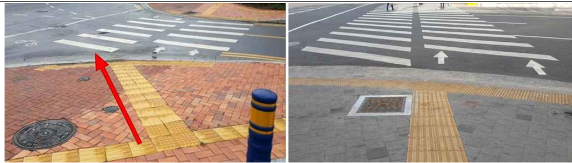
시각장애인을 차도로 안내하는 '엠펙터리 점자블록'
